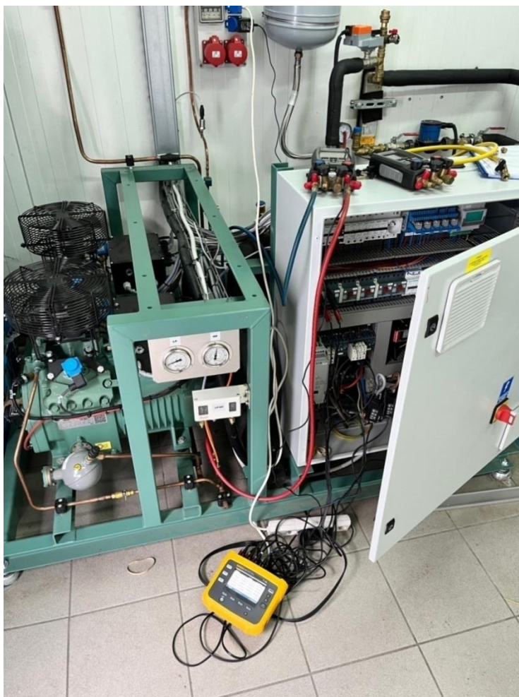
Rys. 3.9. Zdjęcie stanowiska badawczego uwzględniające manometry oraz analizator energii
