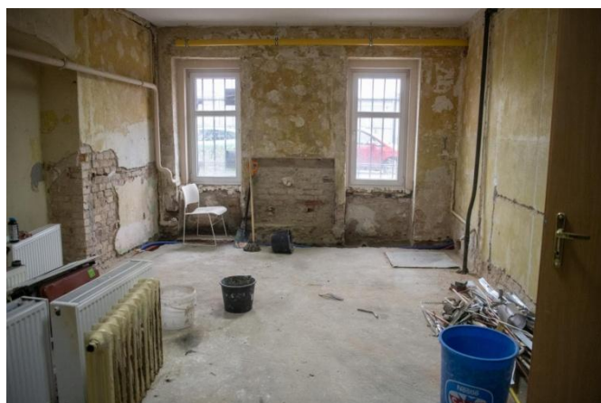
Ryc.93. Galeria Szczur, dokumentacja przestrzeni w trakcie adaptacji, fot. Łukasz Gdak 379
