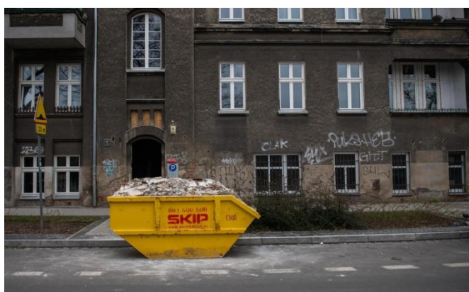
Ryc.92. Galeria Szczur, dokumentacja przestrzeni w trakcie adaptacji, fot. Łukasz Gdak 378
