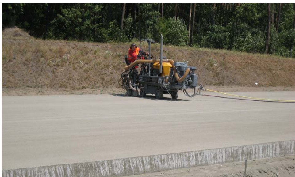
Rysunek 28. Proces cięcia szczelin skurczowych w nawierzchni betonowej
