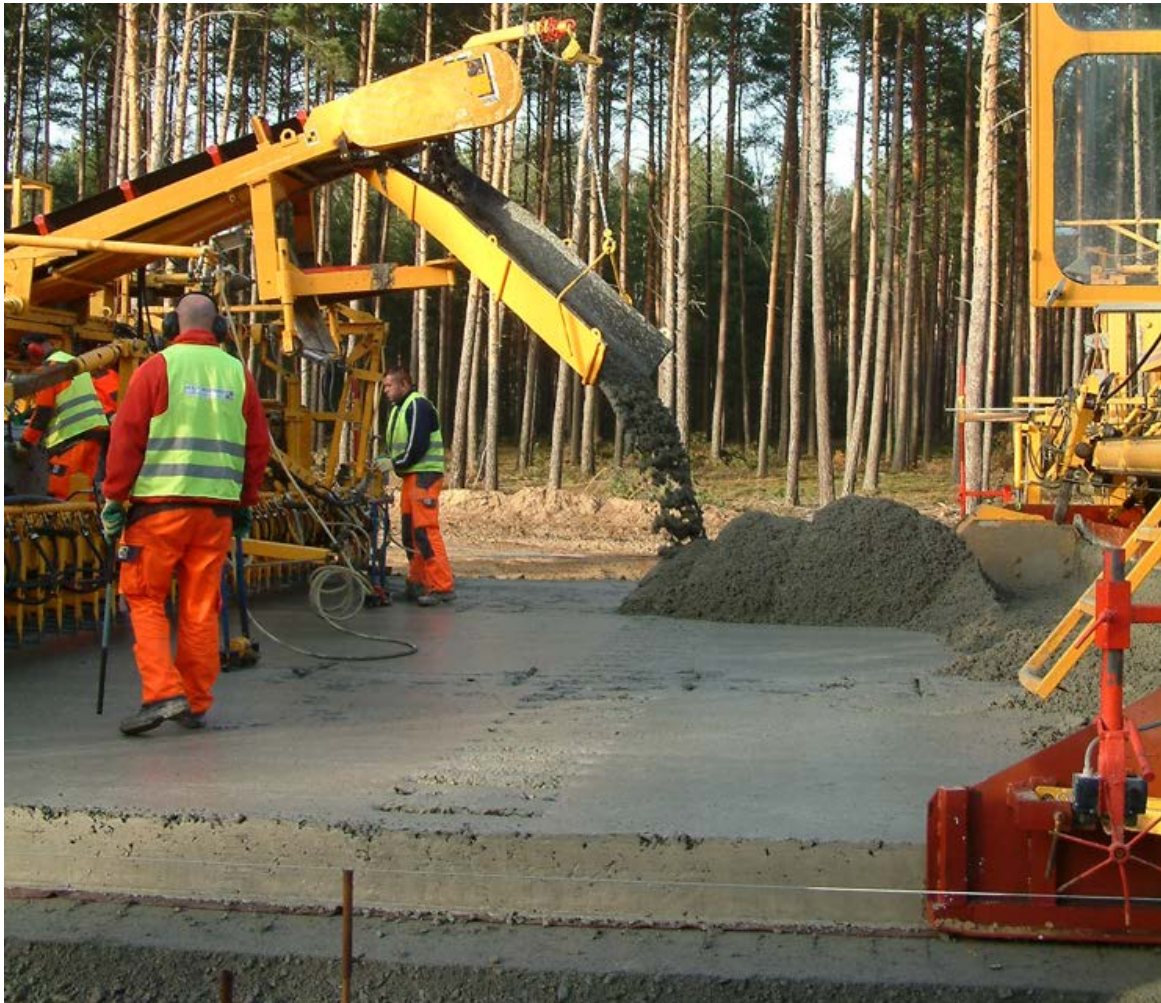
Rysunek 22. Taśmociąg transportujący beton do układarki górnej warstwy betonu
