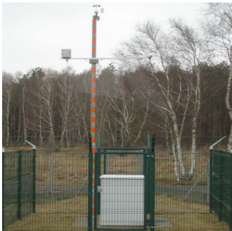
Rysunek 52. Przykładowa drogowa stacja meteorologiczna zlokalizowana na jednym z analizowanych odcinków
