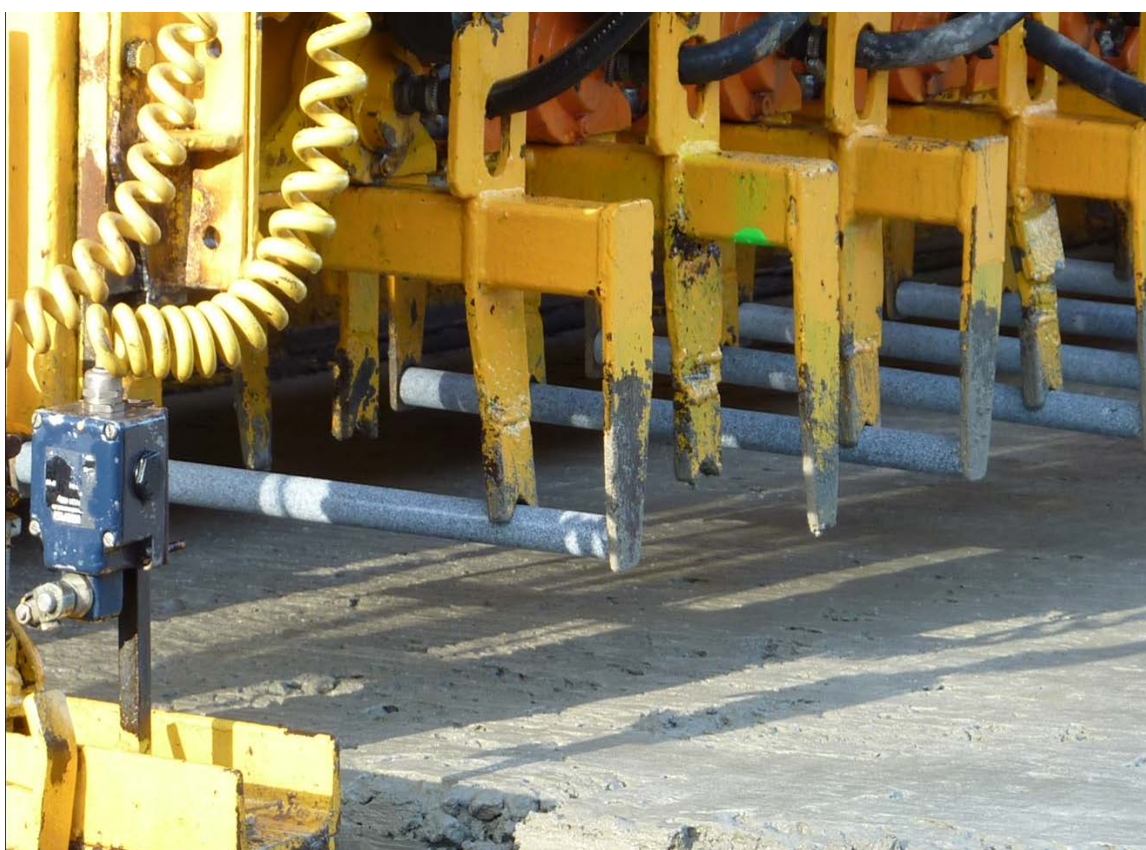
Rysunek 24. Automatyczny proces umieszczania dybli w mieszance betonowej
