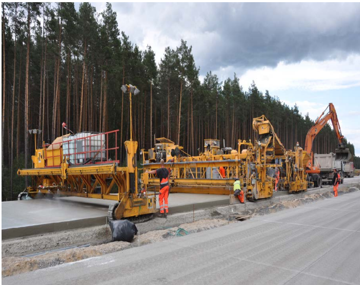
Rysunek 21. Zestaw do układania ślizgowego mieszanki betonowej
