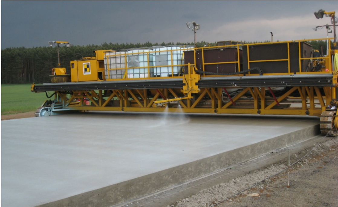
Rysunek 26. Pielęgnacja górnej warstwy nawierzchni betonowej
