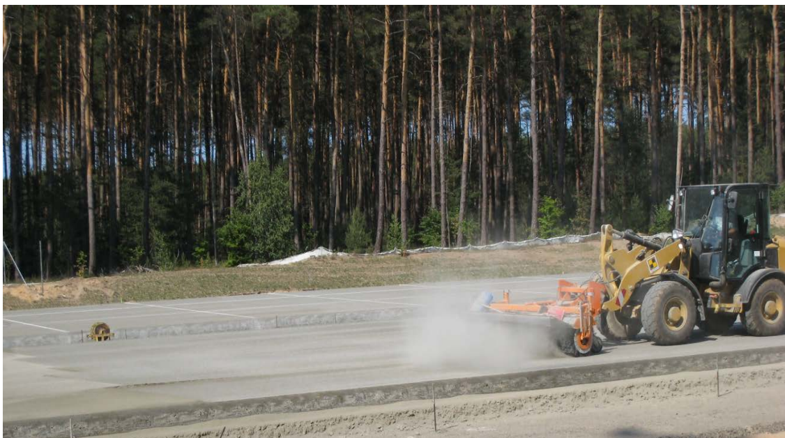
Rysunek 27. Nadawanie powierzchni jezdni z betonu cementowego odpowiedniej tekstury
