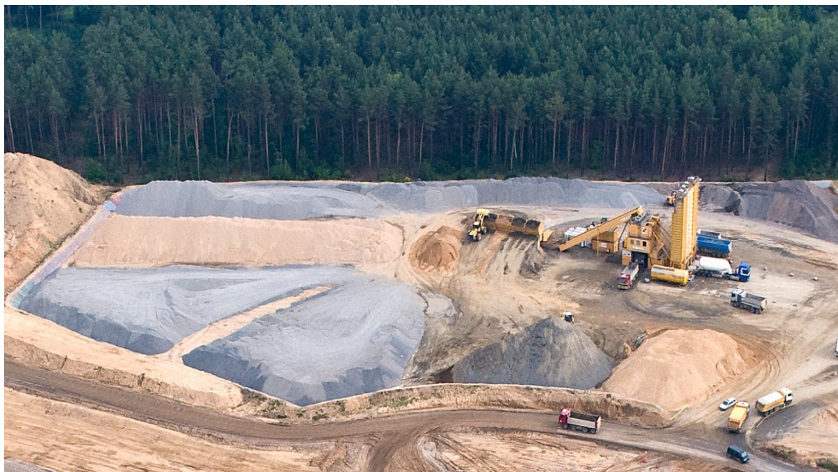
Rysunek 19. Wytwórnia mieszanki betonowej zlokalizowana na Odcinku D
