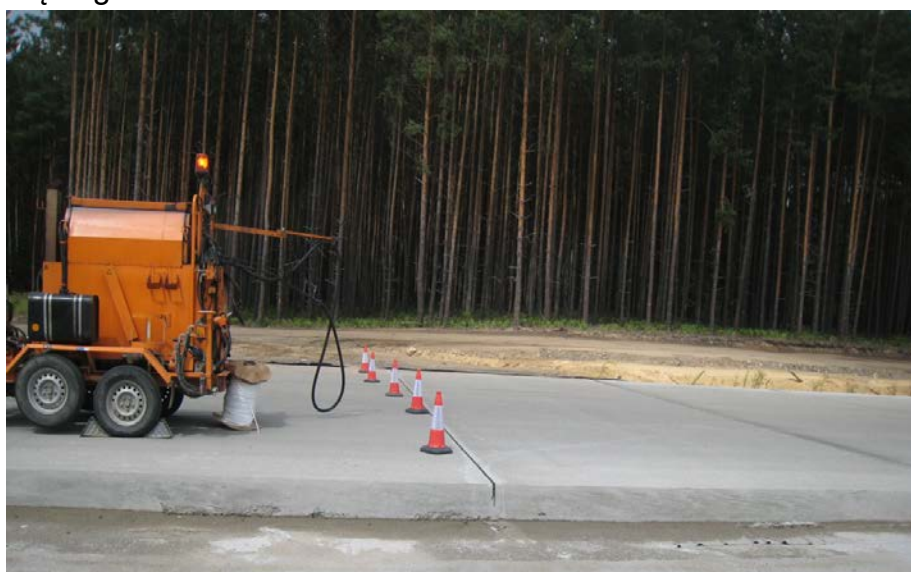
Rysunek 29. Proces mechanicznego wypełniania szczelin w nawierzchni z betonu cementowego
