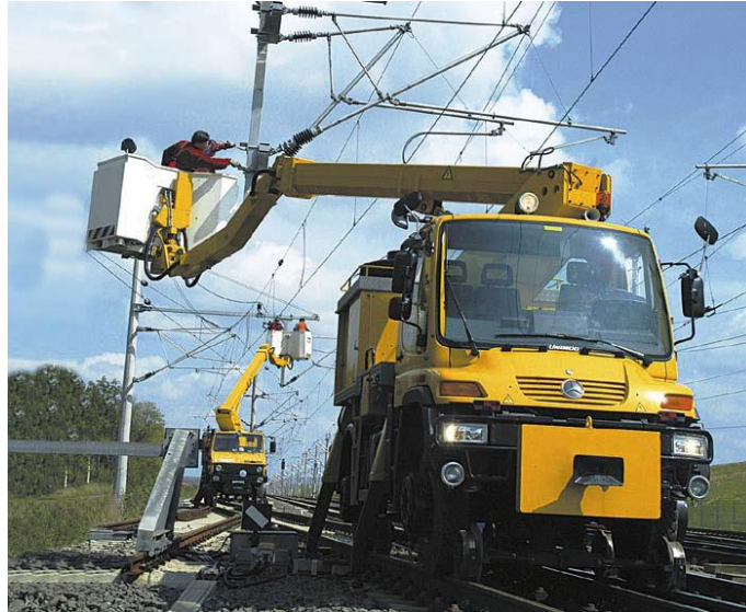
Rys. 1.9. Naprawa sieci trakcyjnej przy wykorzystaniu pojazdu szynowo-drogowego wyposażonego w podnośnik koszowy [6]
