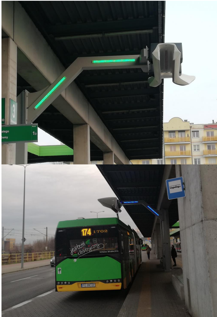
Rys. 4.4 Ładowarka typu pantografowego na dworcu autobusowym na Os. Sobieskiego w Poznaniu (fot. autor)
