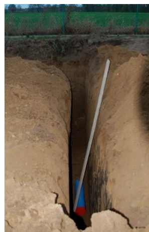
Rys. 3–5. Gruntowy wymiennik ciepła podczas montażu
