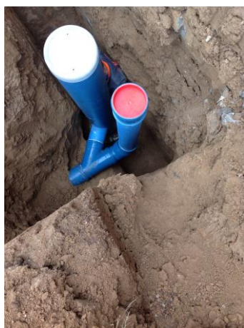
Rys. 3–4. Gruntowy wymiennik ciepła podczas montażu (podejście pod terenową czerpnię powietrza i studzienka na skropliny)
