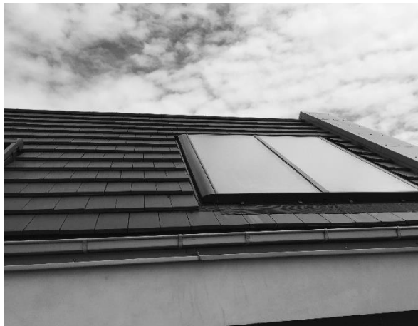
Rys. 3–9. Kolektory słoneczne termiczne Vitosol – 200F
