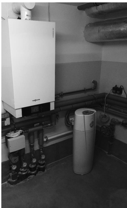
Rys. 3–6. Gazowy kocioł kondensacyjny Vitodens 300
