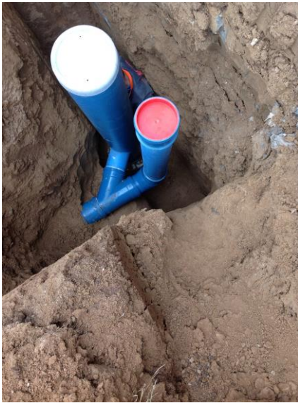
Rys. 3–11. Gruntowy wymiennik ciepła podczas montażu (podejście pod terenową czerpnię powietrza i studzienka na skropliny)
