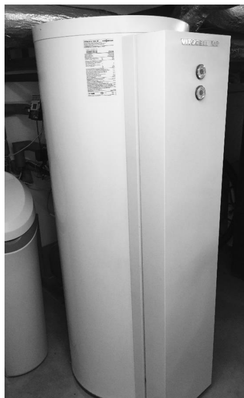
Rys. 3–7. Podgrzewacz pojemnościowy Vitocell – 100 W
