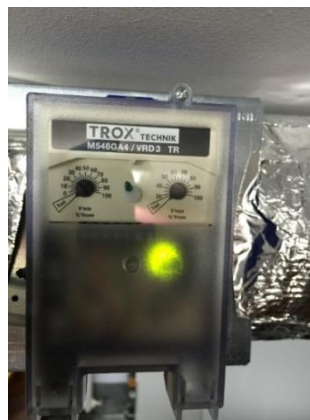
Rys. 3–17. Przetwornik przepływu powietrza w układzie wentylacji mechanicznej
