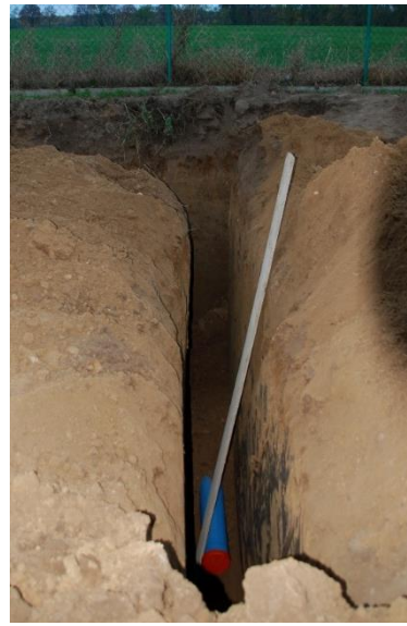
Rys. 3–12. Gruntowy wymiennik ciepła podczas montażu
