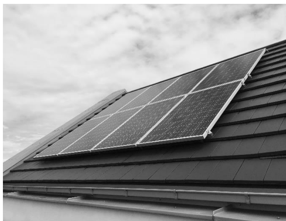
Rys. 3–8. Moduły fotowoltaiczne Vitovolt 300 (2 kWp)
