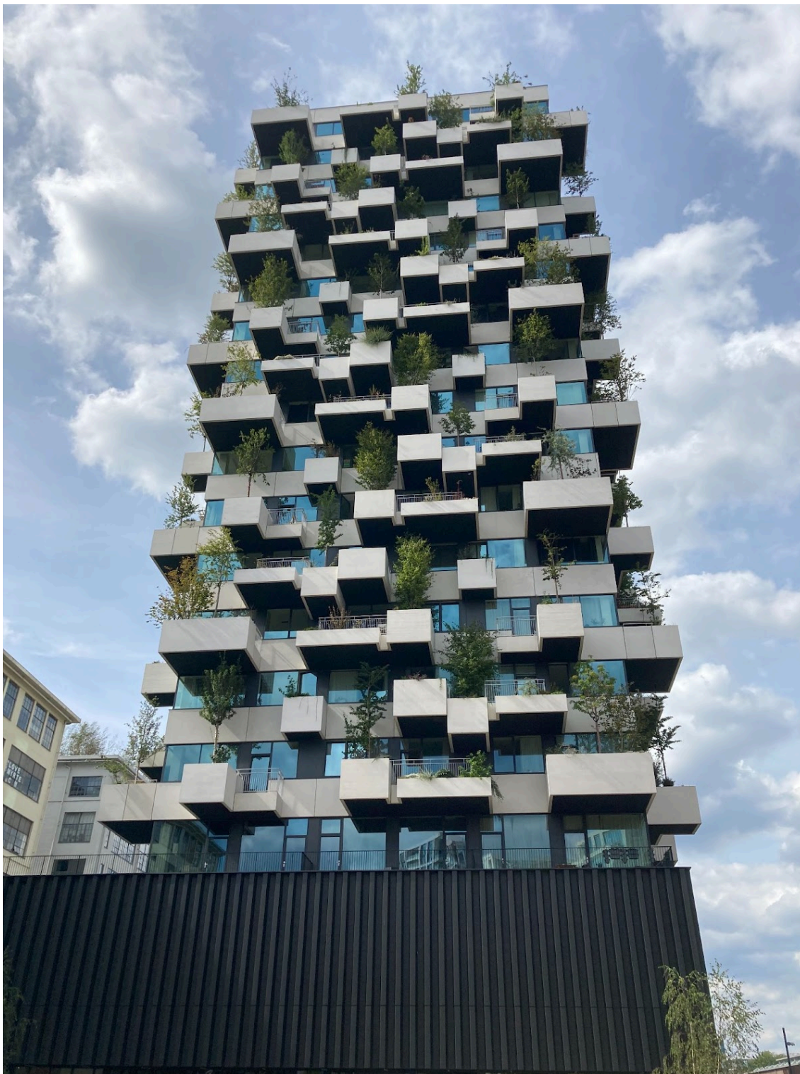
Ryc. 126. Budynek socjalny Trudo Vertical Forest w Eindhoven, którego balkony podtrzymują ponad 10 000 roślin. Fot. z archiwum A. Ptak-Wojciechowska.
