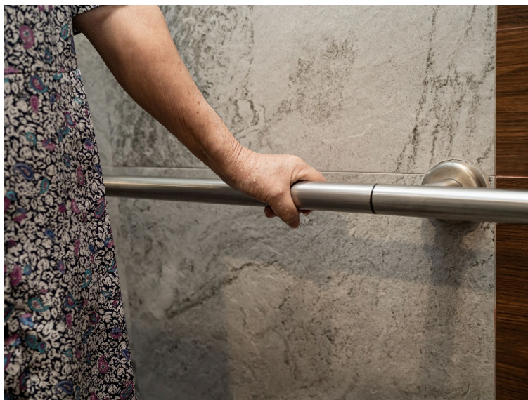
Ryc. 102. Przykład inkluzywności budynku publicznego, osiągniętej poprzez zainstalowanie poręczy. Źródło: licencja bezpłatna AdobeStock_392906626.
