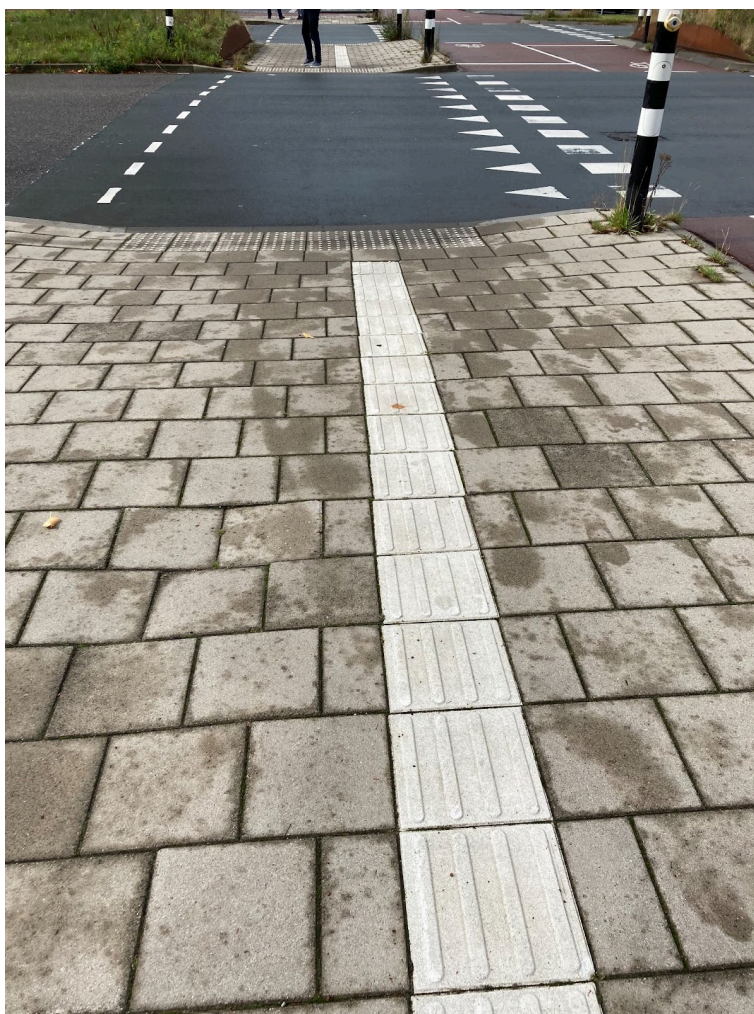
Ryc. 107. Dostępność chodnika w Utrecht dla pieszych. Lokalnie obniżone progi, płytki ostrzegawcze i kierujące dla niewidomych. Fot. z archiwum A. Ptak-Wojciechowska.
