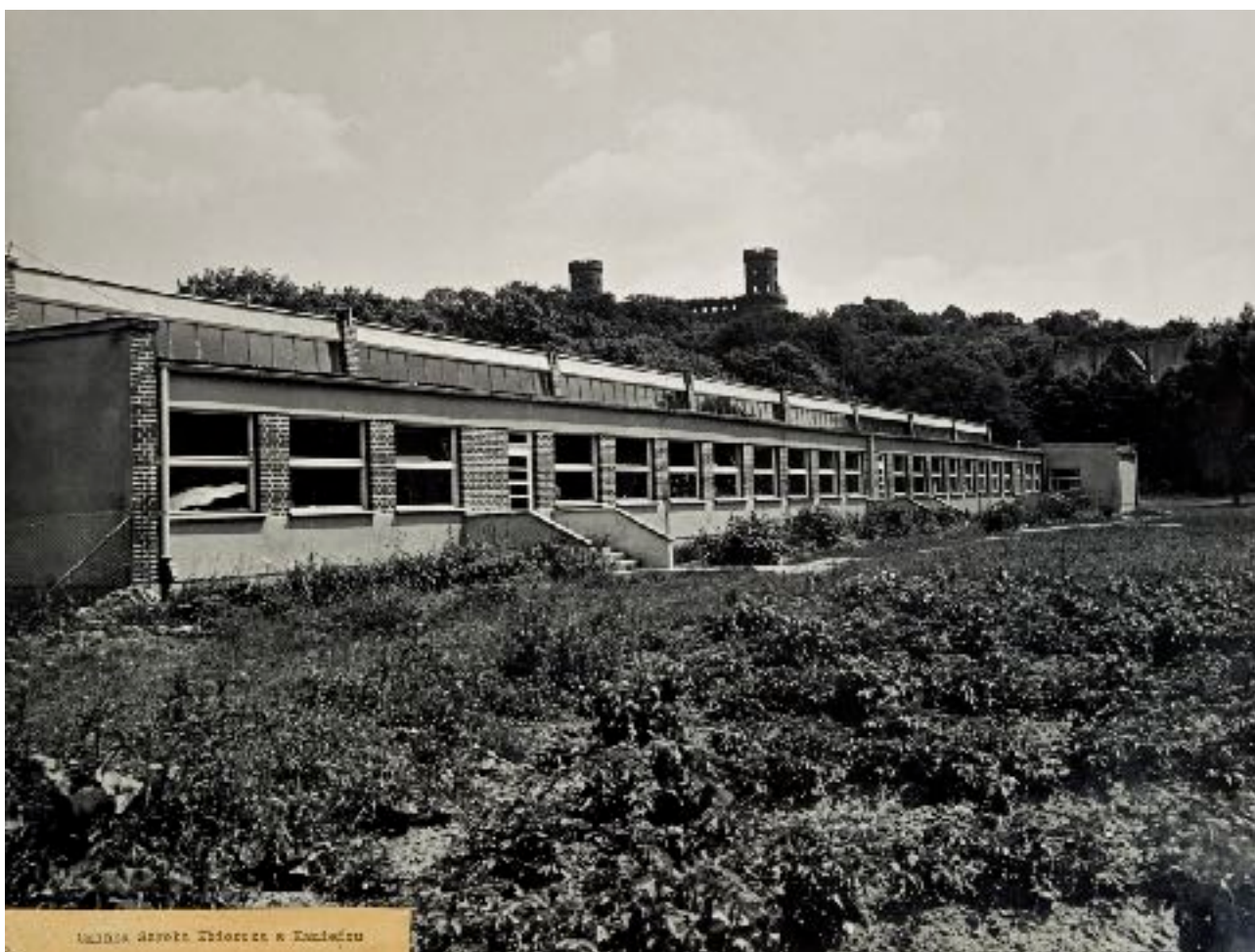
29. Budynek szkoły podstawowej w Kamieńcu Ząbkowickim, elewacja tylna
