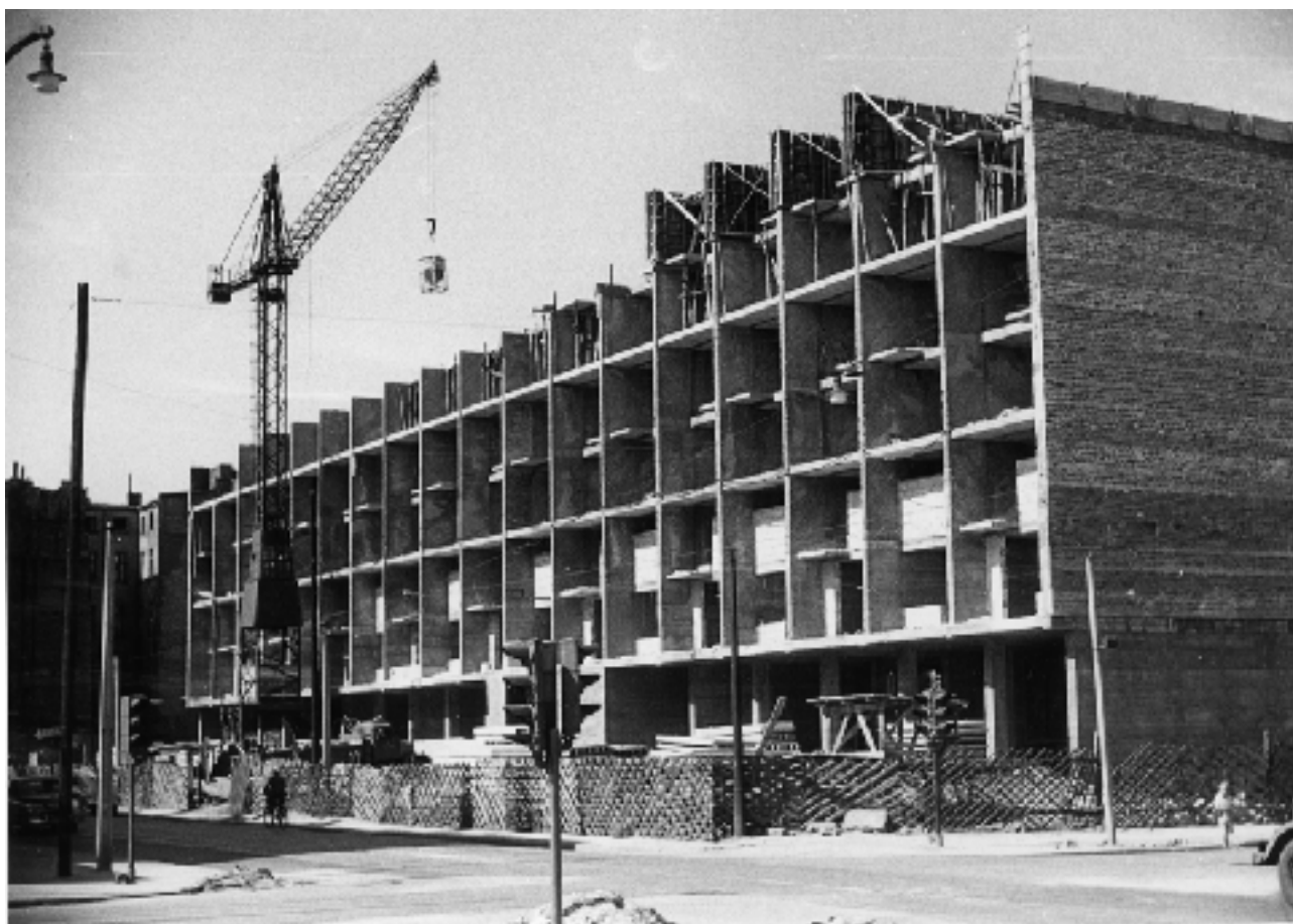
112. Galeria w trakcie budowy
