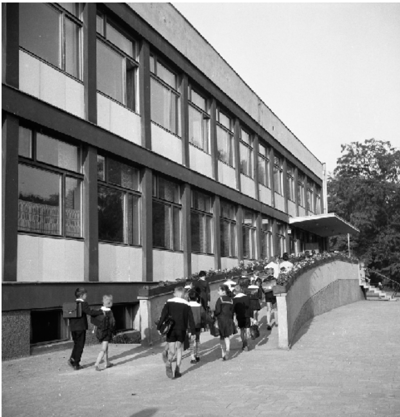
33. Szkoła podstawowa przy ulicy Podwale, uczniowie w drodze na lekcje
