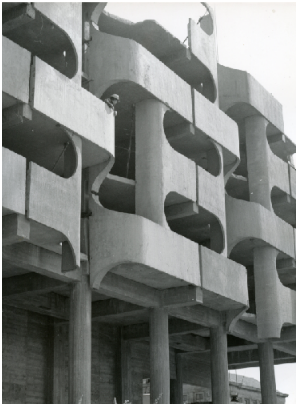
60. Wieżowiec mieszkalny przy placu Grunwaldzkim 4a w trakcie budowy
