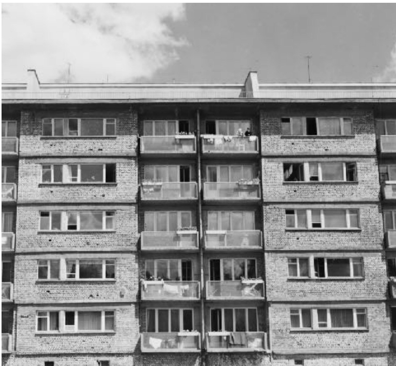
16. Elewacja budynku przy ulicy Teatralnej przed otynkowaniem
