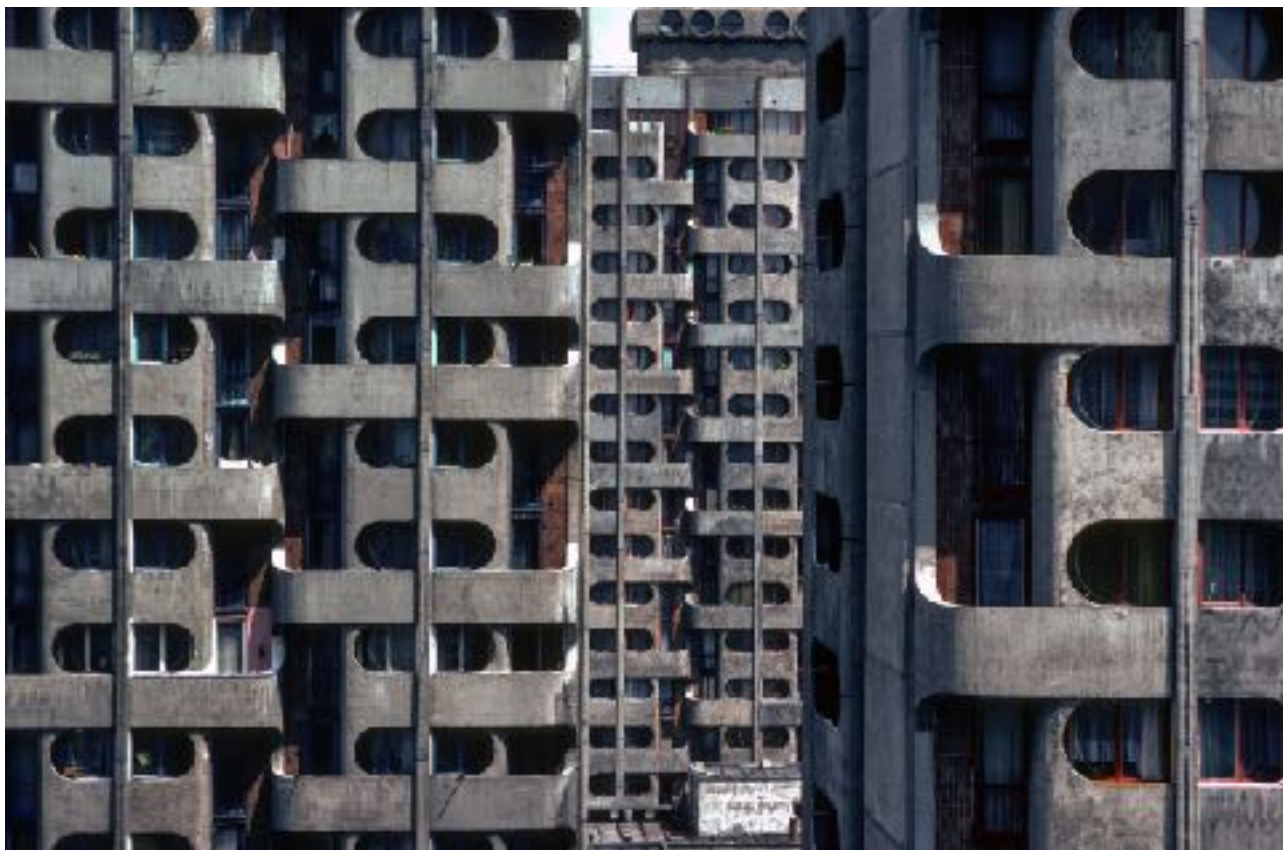
63. Elewacje budynków mieszkalnych, 1982 rok
