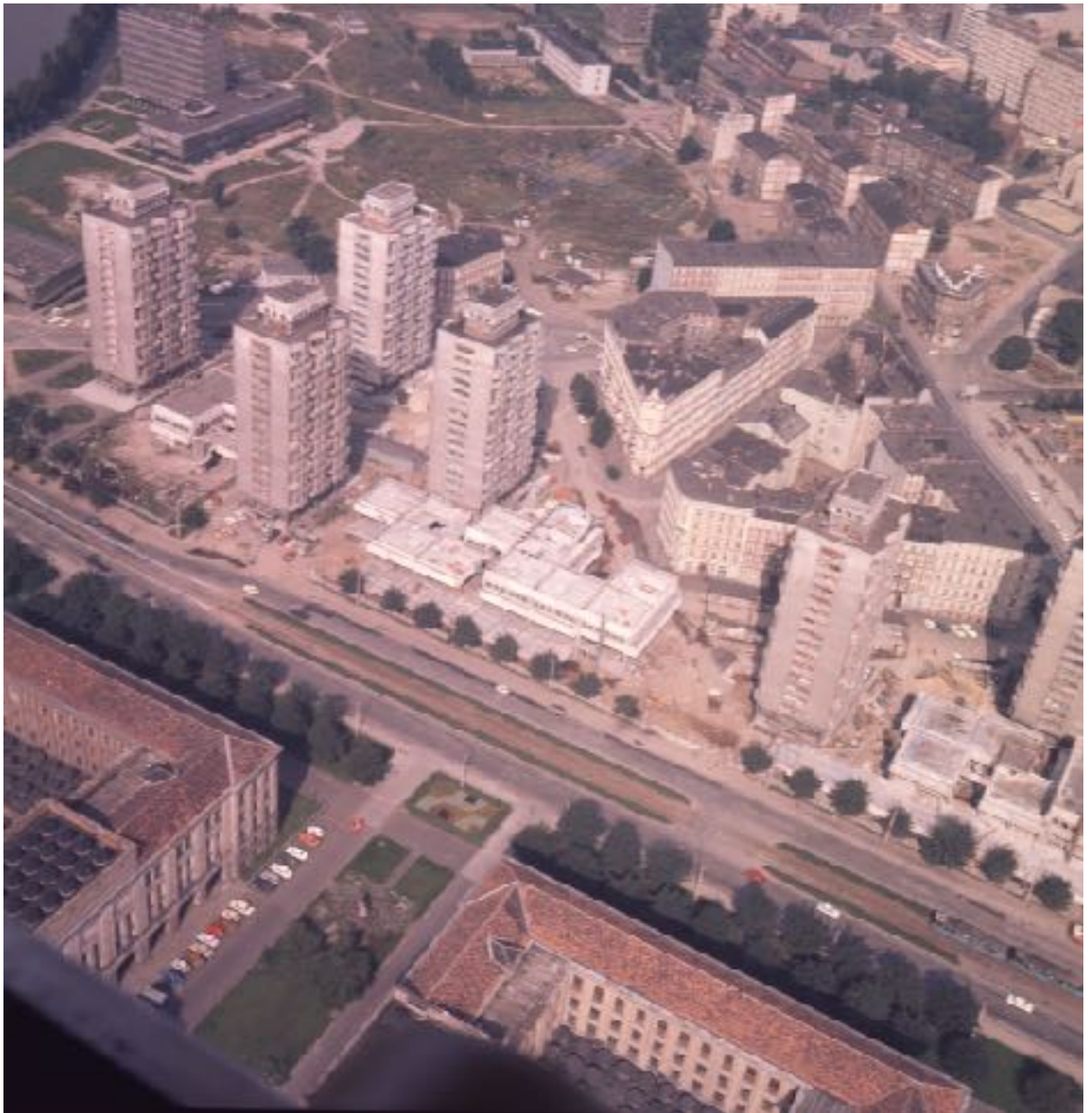
62. Budowa zespołu mieszkaniowego przy placu Grunwaldzkim
