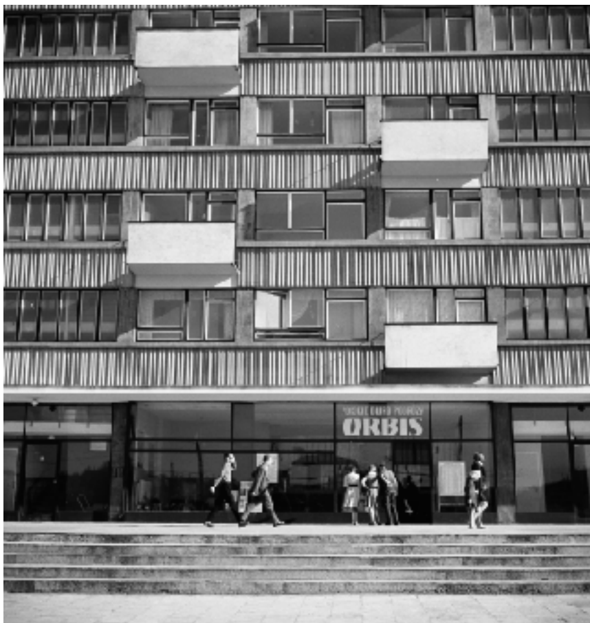
113. Dom Naukowca, platforma dla pieszych z lokalami usługowymi i detale elewacji
