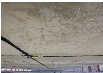
Rysunek 31 Przykłady zarysowań elementu: a) rysy rozproszone, b) rysa horyzontalna gr. ok. 0,5 mm
