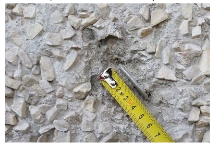
d) widoczna stalowa szpilka
