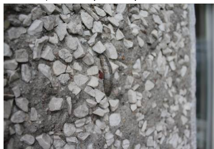
c) widoczny stalowy wieszak
