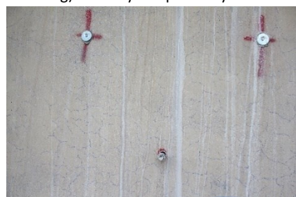
g) siatka rys rozproszonych
