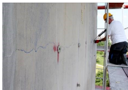
Rysunek 31 Przykłady zarysowań elementu: a) rysy rozproszone, b) rysa horyzontalna gr. ok. 0,5 mm
