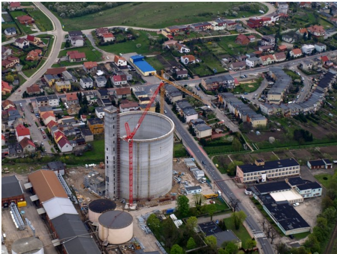
RYSUNEK 5.1: Zdjęcie silosu cukrowniczego w Gostyniu podczas budowy - archiwum GT Projekt
