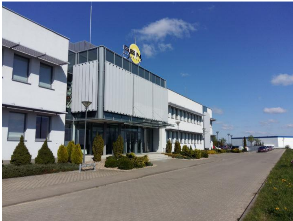
Ilustracja 171: Budynek biurowy firmy G.EN. w Tarnowie Podgórnym. Zdjęcie wykonano 20.04.2017 r.
