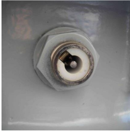
Rys. 2.12. Gniazdo pomiarowe ze sprężyną uziemiającą i litym trzpieniem o średnicy 4mm
