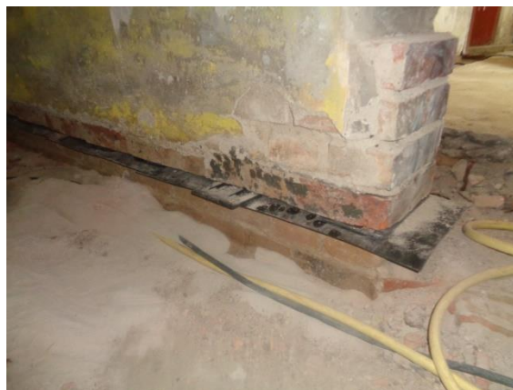
Fot. 3.4 Membrana hydroizolacyjna umieszczona w nacięciu muru (fot.: autor)
