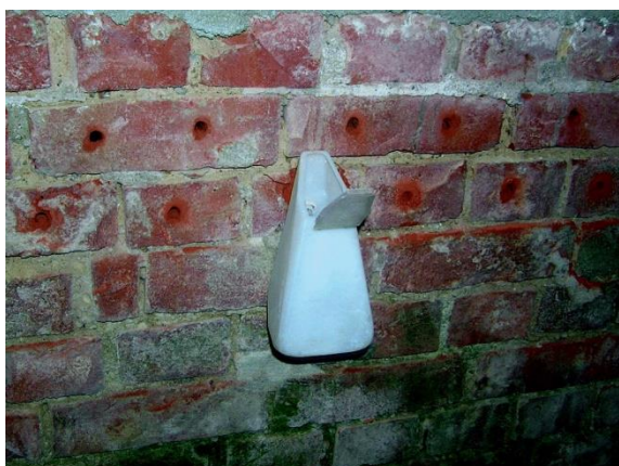
Fot. 4.5 W handlu dostępne są różnego rodzaju zasobniki wykorzystujące siłę ciężkości, ale również takie, które wykorzystują siły spójności (syfon) [171] (fot.: [193])
