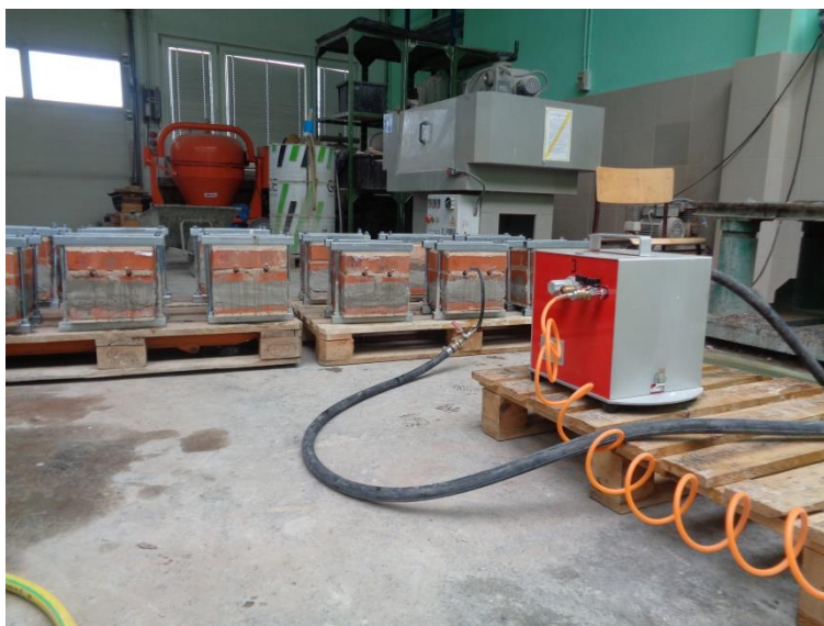
Fot. 6.3 Iniekcja niskociśnieniowa (fot.: autor)
