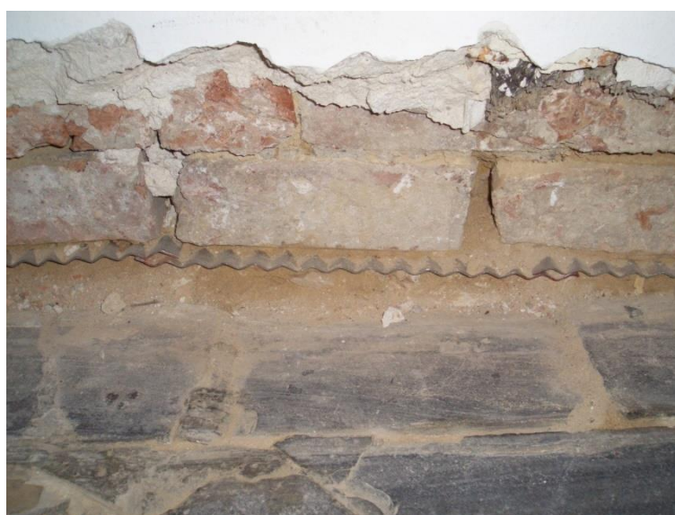
Fot. 3.2 Wciskanie blachy ze stali szlachetnej (fot.: Wikimedia Commons)
