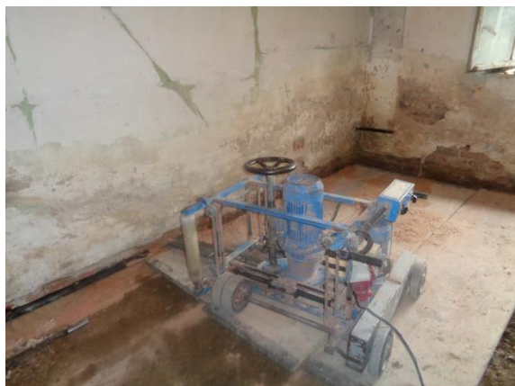
Fot. 3.3 Podcinanie muru piłą tarczową (fot.: autor)
