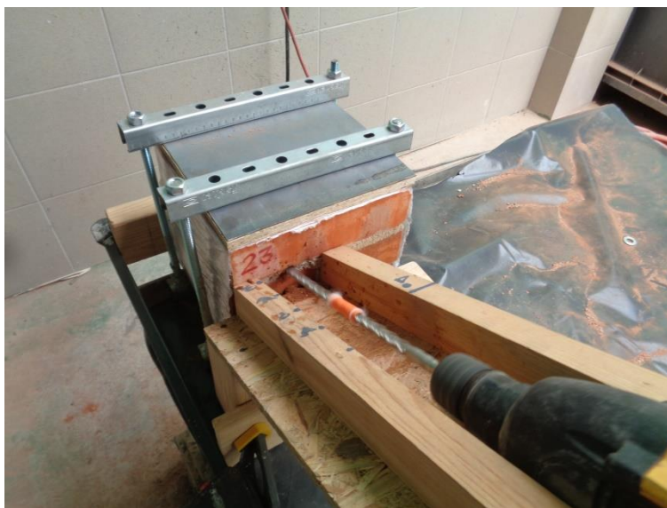
Fot. 6.2 Wykonywanie nawierzeń – iniekcja niskociśnieniowa (fot.: autor)
