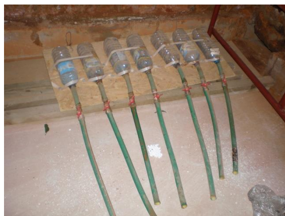
Fot. 4.6 W praktyce często wykorzystywane są dozowniki wykonane „metodą chatupniczą” (fot.: [126])
