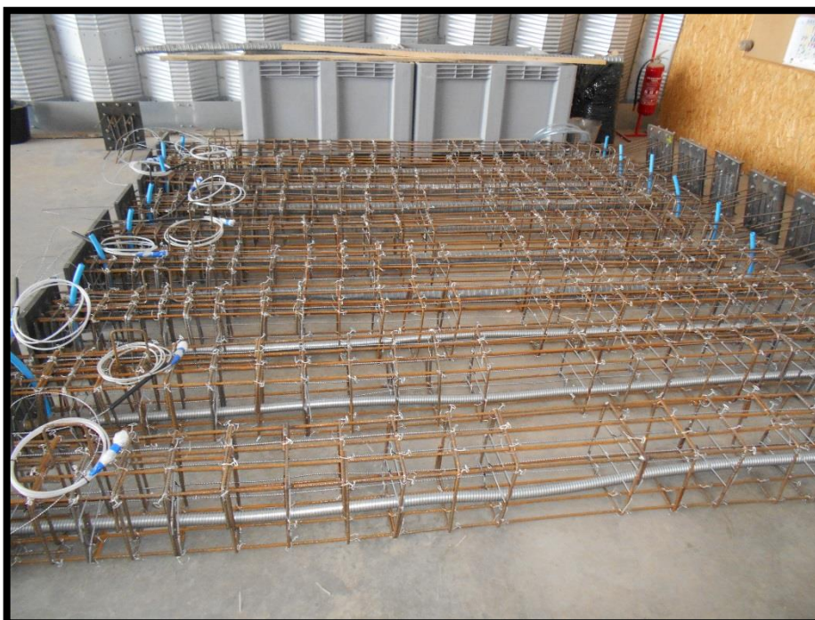
Fot. 5.3 Kosze zbrojeniowe belek przed zabetonowaniem
