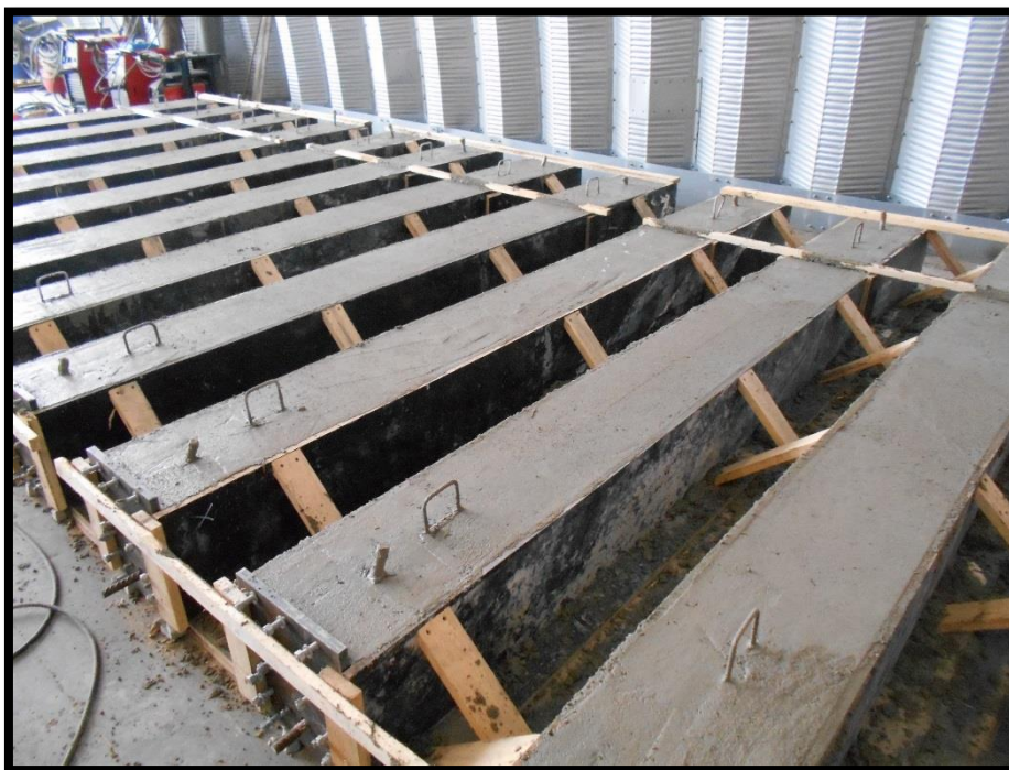
Fot. 5.5 Belki bezpośrednio po zabetonowaniu
