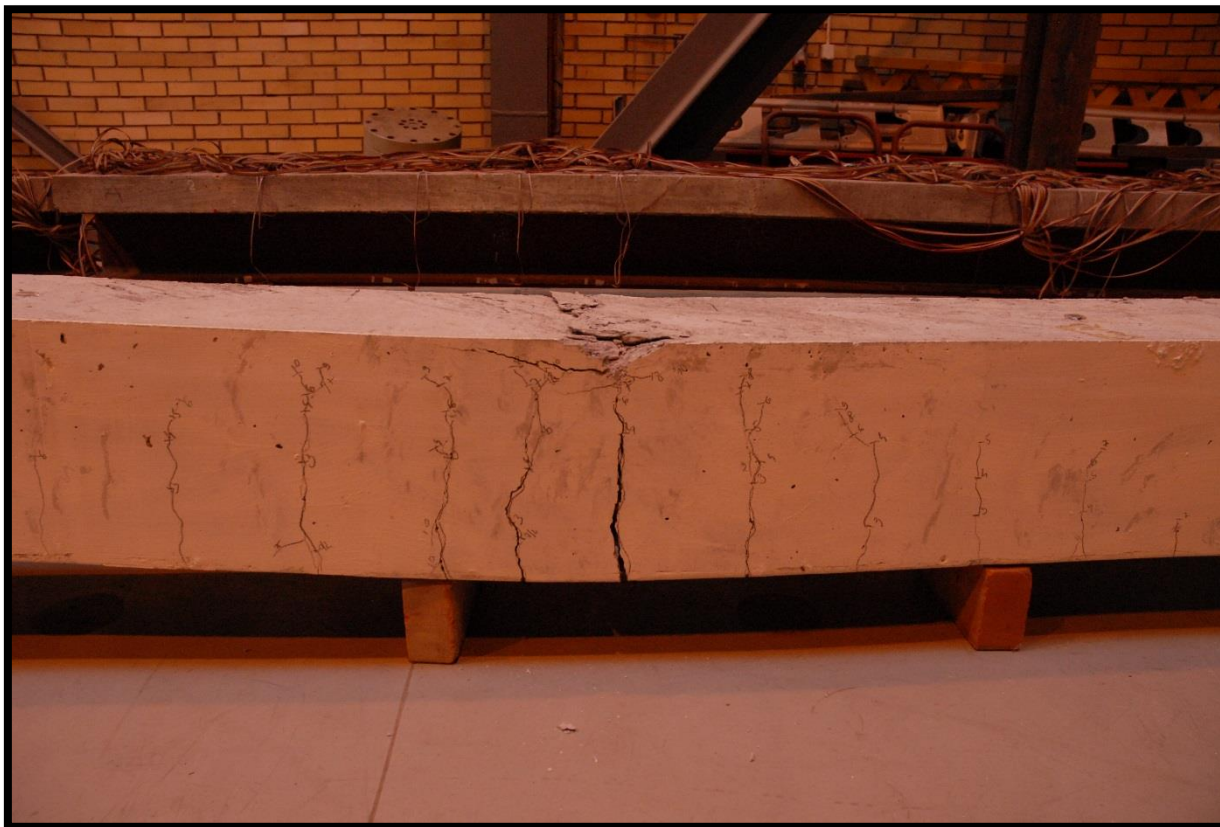
Fot. 5. 32 Belka nr 10 po osiągnięciu SGN
