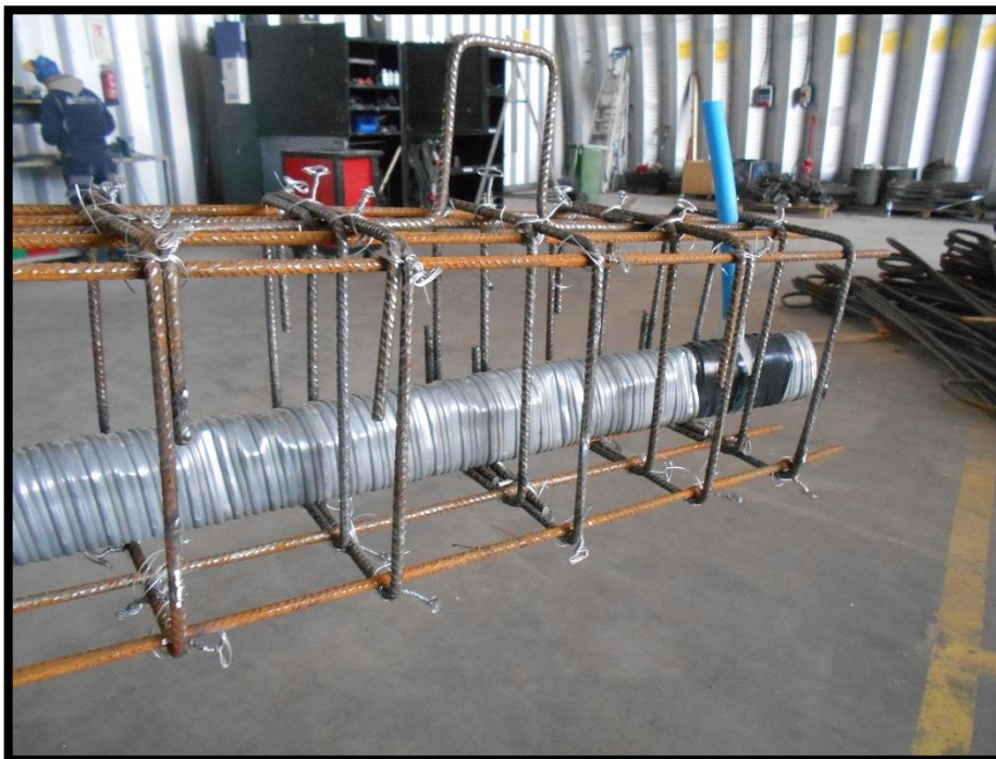
Fot. 5.2 Zbrojenie skrajnego fragmentu części betonowej
