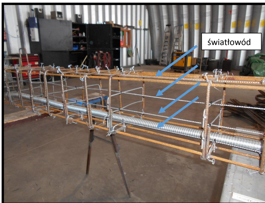
Fot. 5.19 Montaż światłowodu przed betonowaniem
