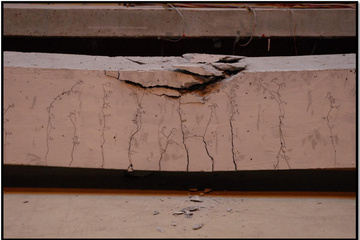
Fot. 5. 27 Belka nr 2 po osiągnięciu SGN
