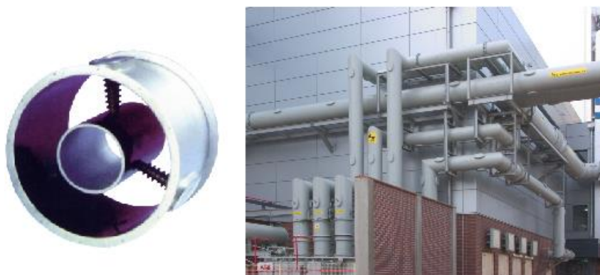
Rys. 1.1. Przekrój i zastosowanie toru wieloprądowego okapturzonego [45]
