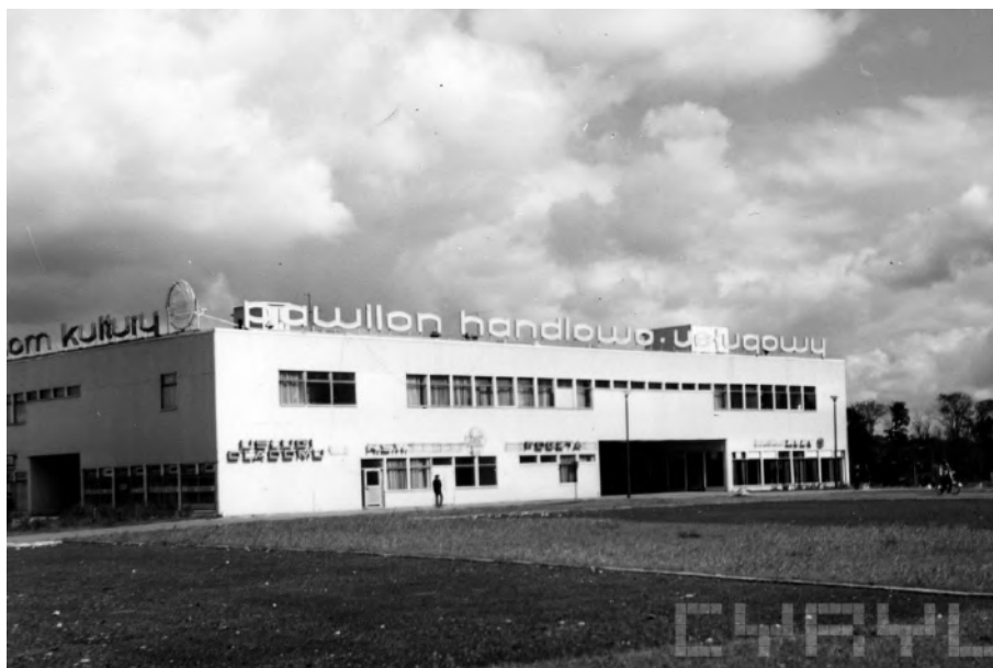
Ryc. 128 Widok na pawilon handlowy położony na osiedlu Lecha, źródło: Cyfrowe Repozytorium Lokalne Poznań – CYRYL
