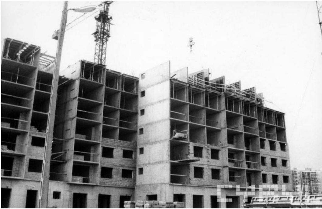
Ryc. 142 Budowa jednostek mieszkalnych na terenie osiedla ZMP, obecne osiedle Orła Białego, źródło: Cyfrowe Repozytorium Lokalne Poznań – CYRYL
