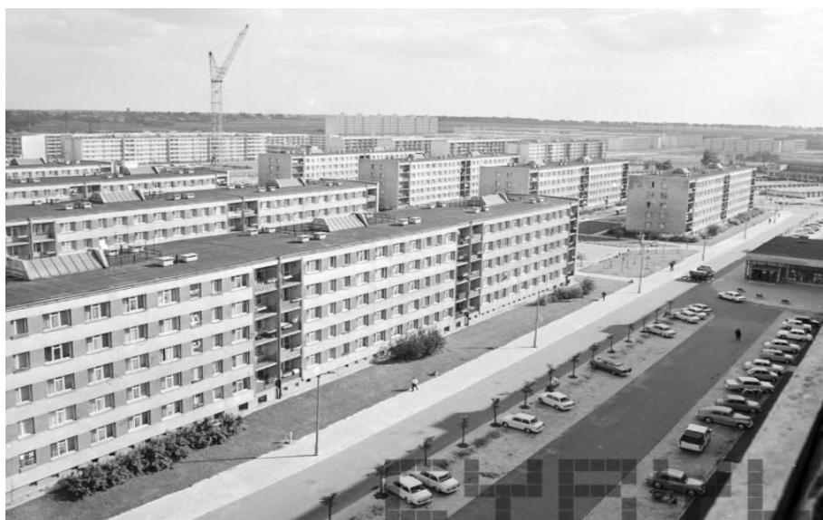
Ryc. 116 Widok na plac budowy – osiedle Piastowskie, źródło: Cyfrowe Repozytorium Lokalne Poznań – CYRYL
