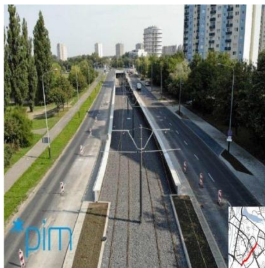
Ryc. 237 Widok po przebudowie na trasę tramwajową wzdłuż ul. Chartowo, źródło: PIM
