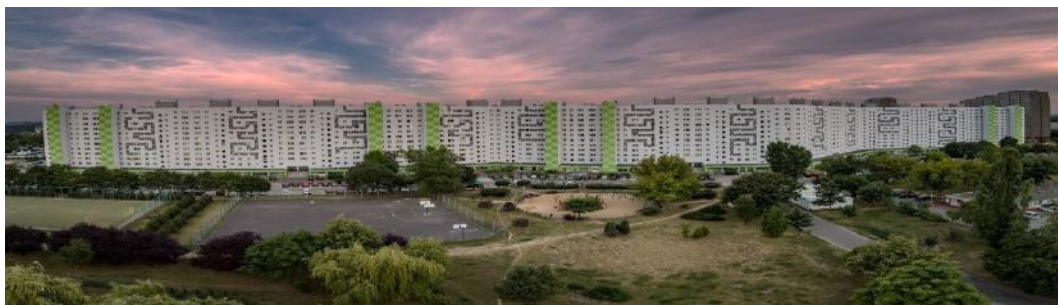
Ryc. 166 Widok na jednostkę mieszkalną położoną na osiedlu Orła Białego po modernizacji elewacji, źródło: dronujemy.com
