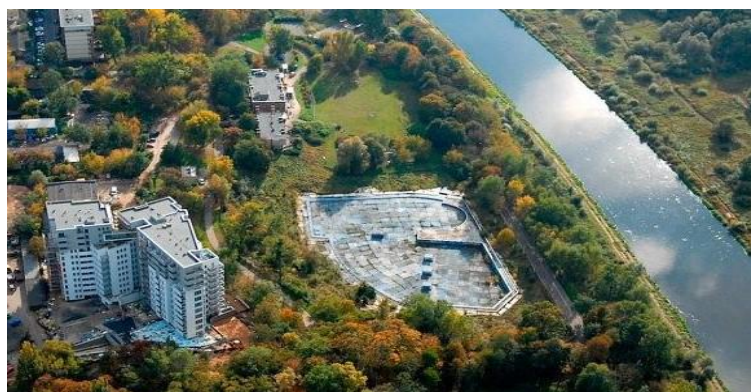
Ryc. 252 Widok z lotu ptaka na odkrytą pływalnię, 2007 rok, źródło: Cyfrowe Repozytorium Lokalne Poznań – CYRYL
