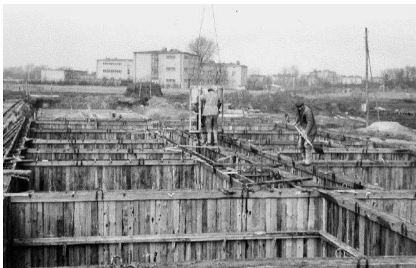
Ryc. 100 Fundamenty pierwszego budynku realizowanego w ramach nowej dzielnicy mieszkaniowej „Rataje”, źródło: „Kroniki Miasta Poznania”
