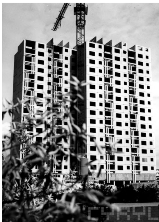
Ryc. 131 Widok na budowę szesnastokondygnacyjnej jednostki położonej na terenie osiedla Piastowskiego, źródło: Cyfrowe Repozytorium Lokalne Poznań – CYRYL
