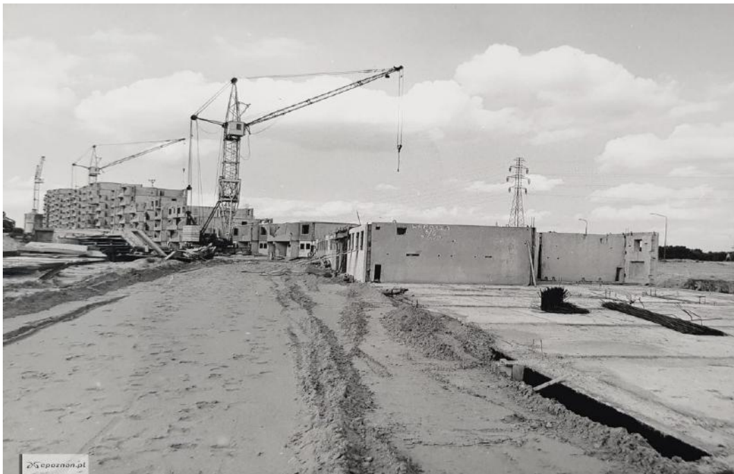
Ryc. 135 Budowa jednostki mieszkalnej zlokalizowanej na terenie osiedla Rusa, źródło: epoznan.pl
