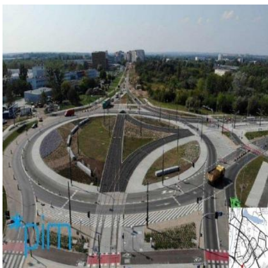
Ryc. 238 Widok na rondo Żegrze po przebudowie, źródło: PIM
