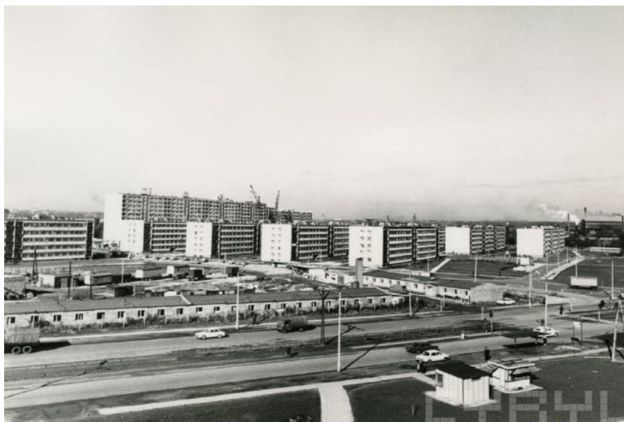
Ryc. 114 Widok na plac budowy – osiedle Piastowskie, źródło: Cyfrowe Repozytorium Lokalne Poznań – CYRYL
