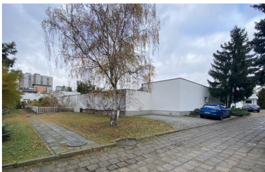
Ryc. 87 Widok na jednostkę mieszkalną – osiedle Zodiak, źródło: autor
