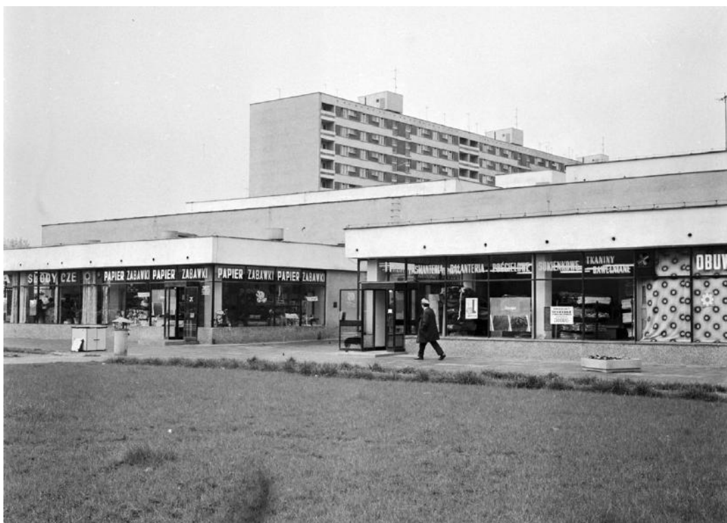
Ryc. 138 Sklep wielobranżowy na terenie osiedla Piastowskiego, źródło: Cyfrowe Repozytorium Lokalne Poznań – CYRYL
