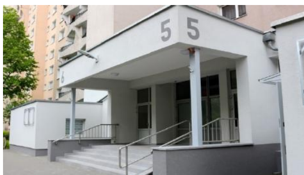
Ryc. 158 Widok na zmodernizowane wejście do budynku mieszkalnego położonego na Ratajach, źródło: Spółdzielnia Mieszkaniowa „Osiedle Młodych”
