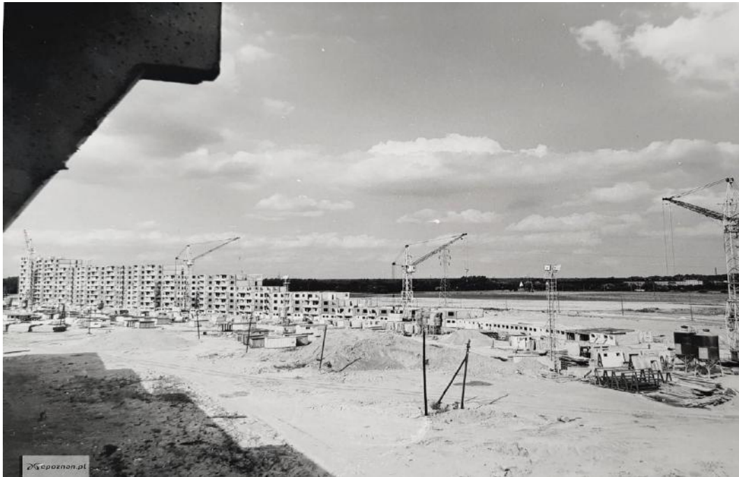
Ryc. 134 Budowa jednostki mieszkalnej zlokalizowanej na terenie osiedla Rusa, źródło: epoznan.pl
