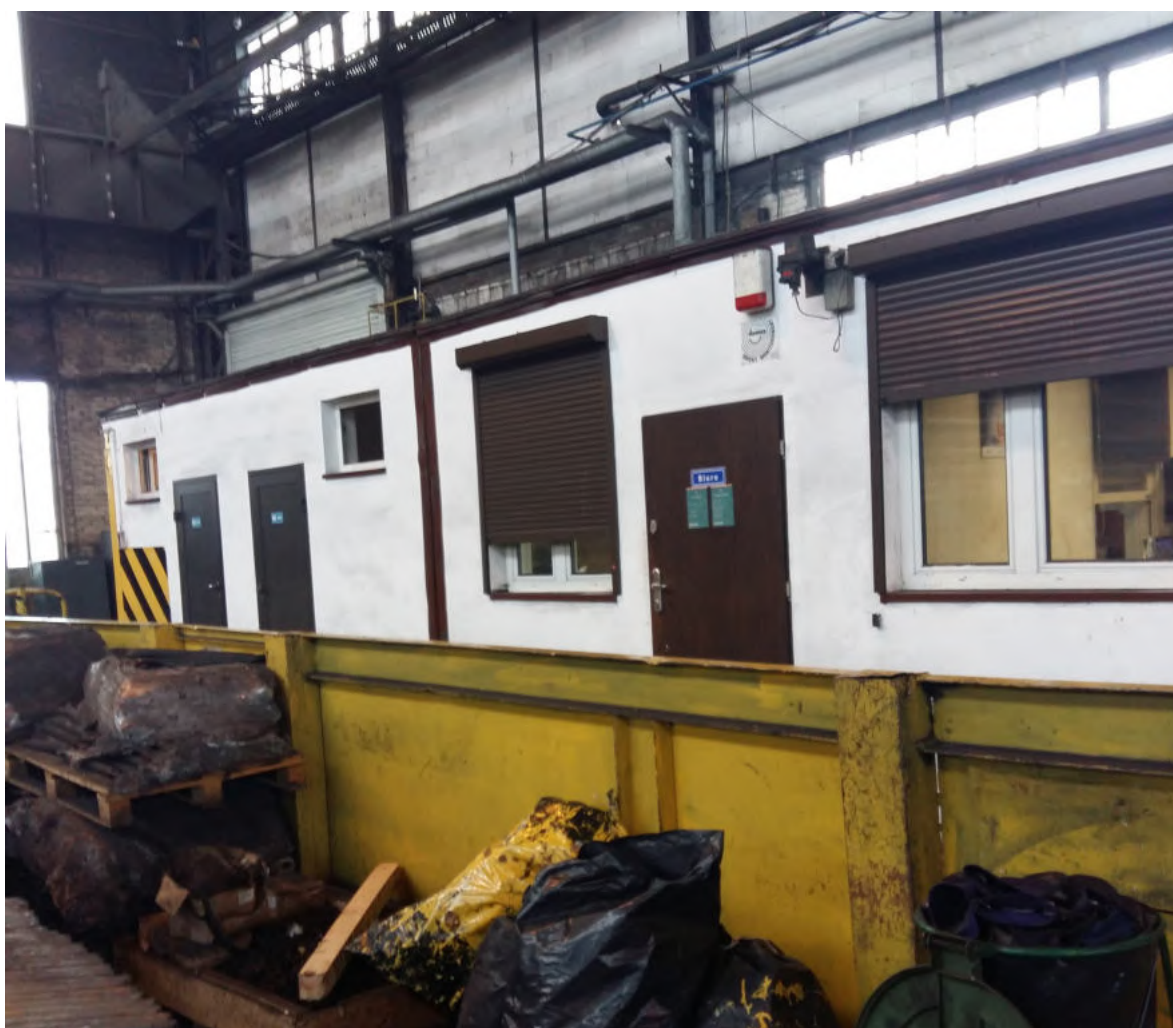
Ilustracja 188: Biuro w hali przemysłowej Huty Łabędy. Zdjęcia wykonano 12.04.2017 r.
