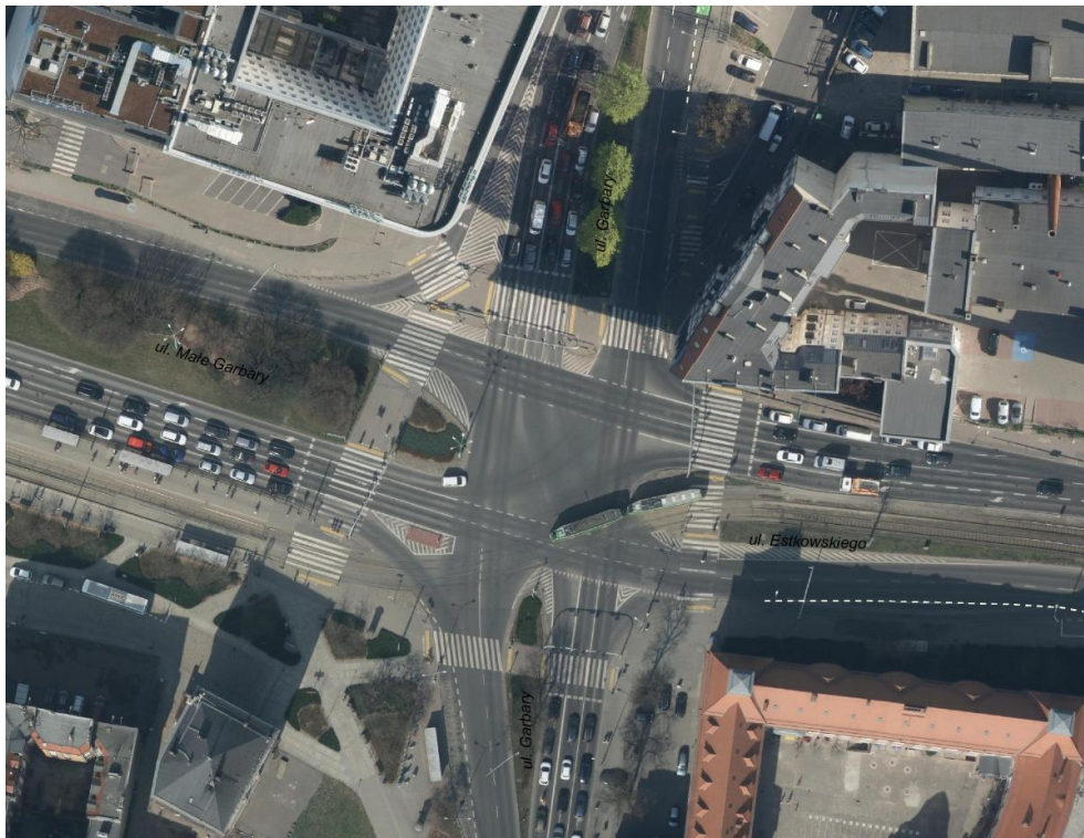
Rys. 45. Skrzyżowanie Garbary-Estkowskiego-Małe Garbary w Poznaniu - przed przebudową. Źródło: Opr. własne na bazie [66]
