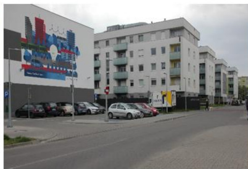
Poznań, os. Zwycięstwa ulica osiedlowa-zabudowa wielorodzinna.
