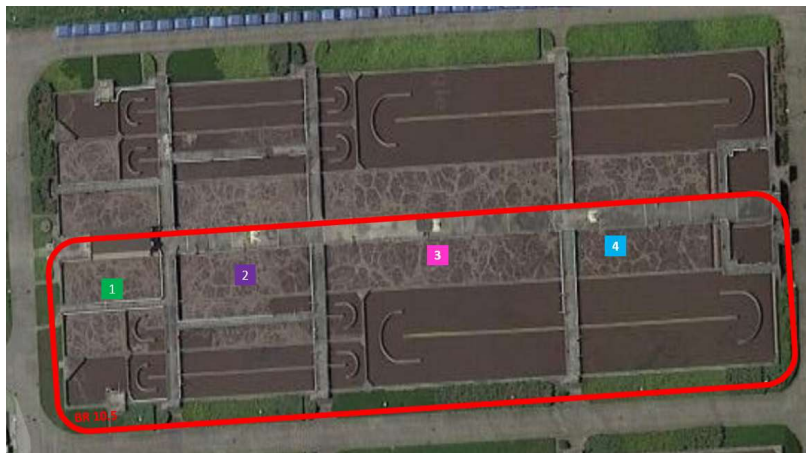
Rysunek 11. Umieszczenie punktów pomiarowych, w których montowano komorę - jeden z bioreaktorów (BR) (obiekt 10.5) COŚ [opracowanie własne].
