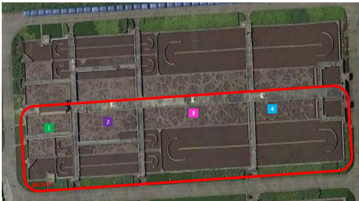
Rysunek 12. Umieszczenie punktów pomiarowych, w których montowano komorę - jeden z bioreaktorów (BR) (obiekt 10.5) COŚ [opracowanie własne].
