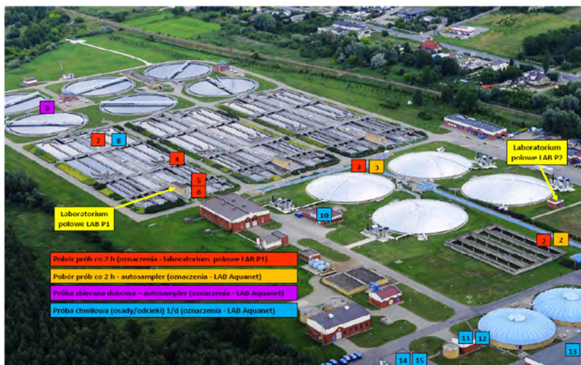
Rysunek 14. Umieszczenie poszczególnych punktów pomiarowych i poborowych próbek - z lotu ptaka [opracowanie – na cele projektu SIREN].
