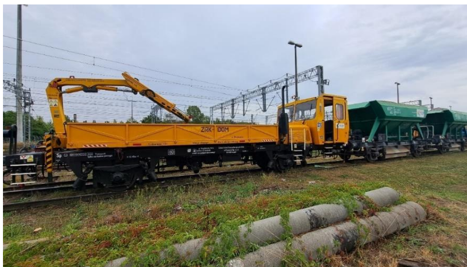
Rys. 7.4. Pojazd WM-15A z dwoma załadowanymi wagonami do przewozu tłucznia
